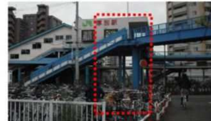
北側エレベータ設置予定箇所
