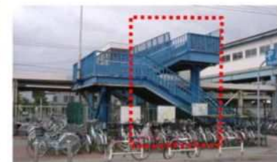
南側エレベータ設置予定箇所
