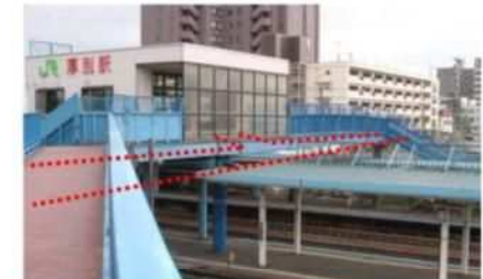
新自由通路設置予定箇所（既設橋の脇に架替）
