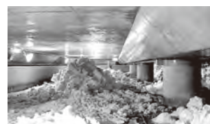
雪冷熱利用(札幌駅北口地区) (融雪槽の雪を冷水熱源に利用)
