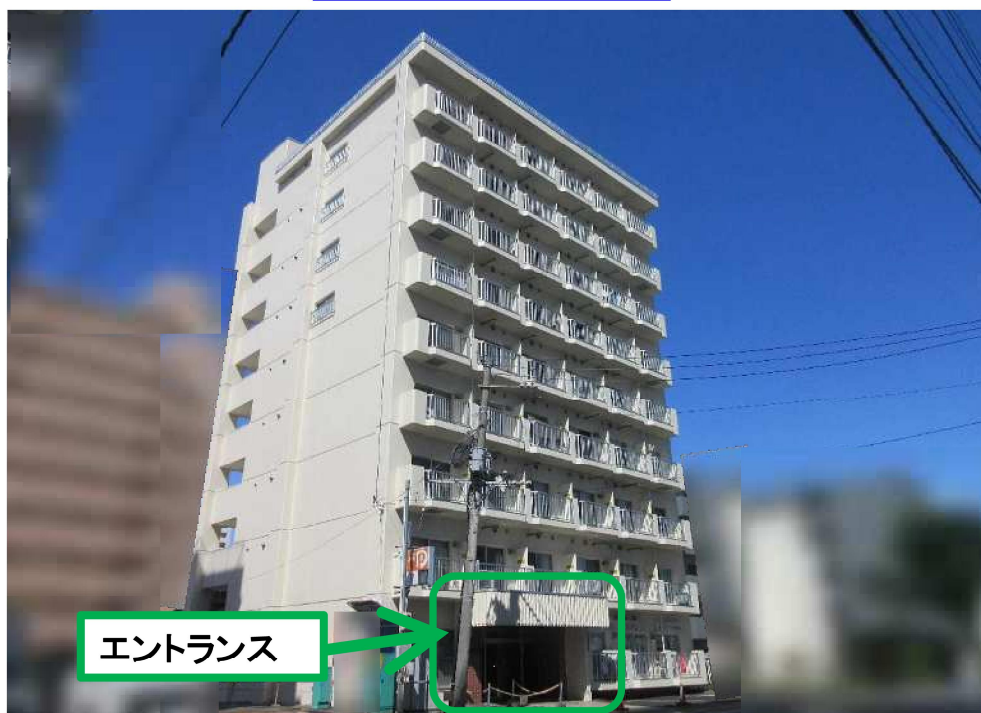
外 観（東側から）
