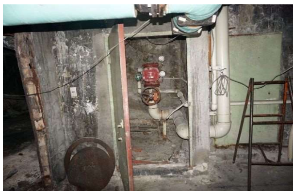
物件9 地下1階 旧ポンプ室
