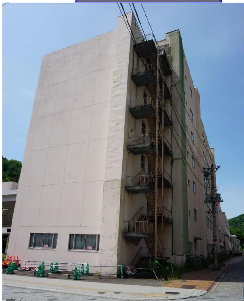
外観（北側より撮影）
