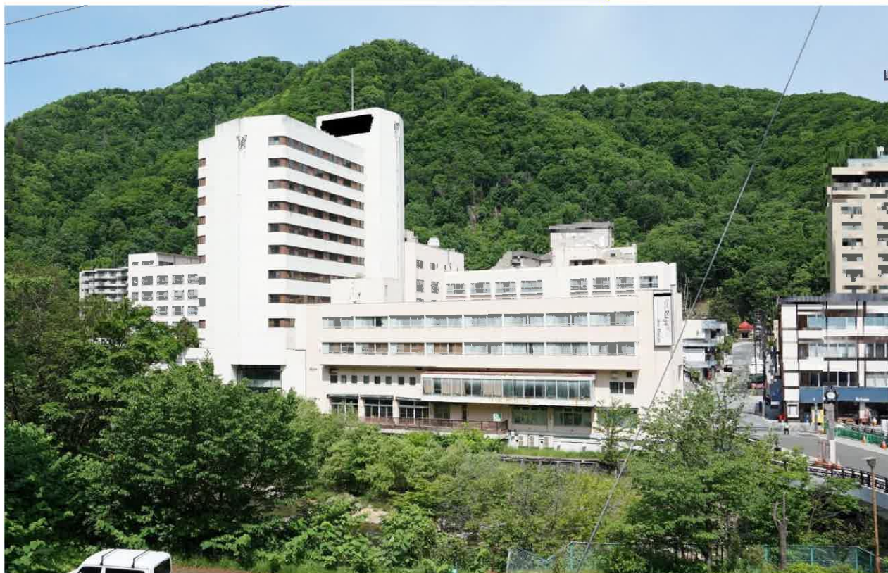
外観（豊平川右岸より）
