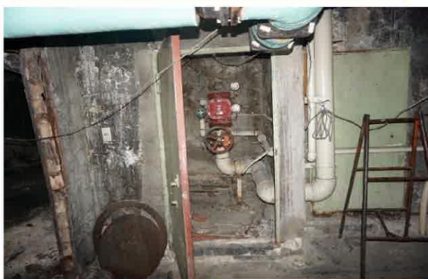
物件9 地下1階 旧ポンプ室
