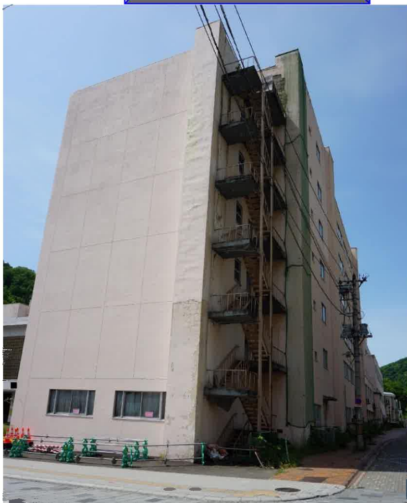
外観（北側より撮影）
