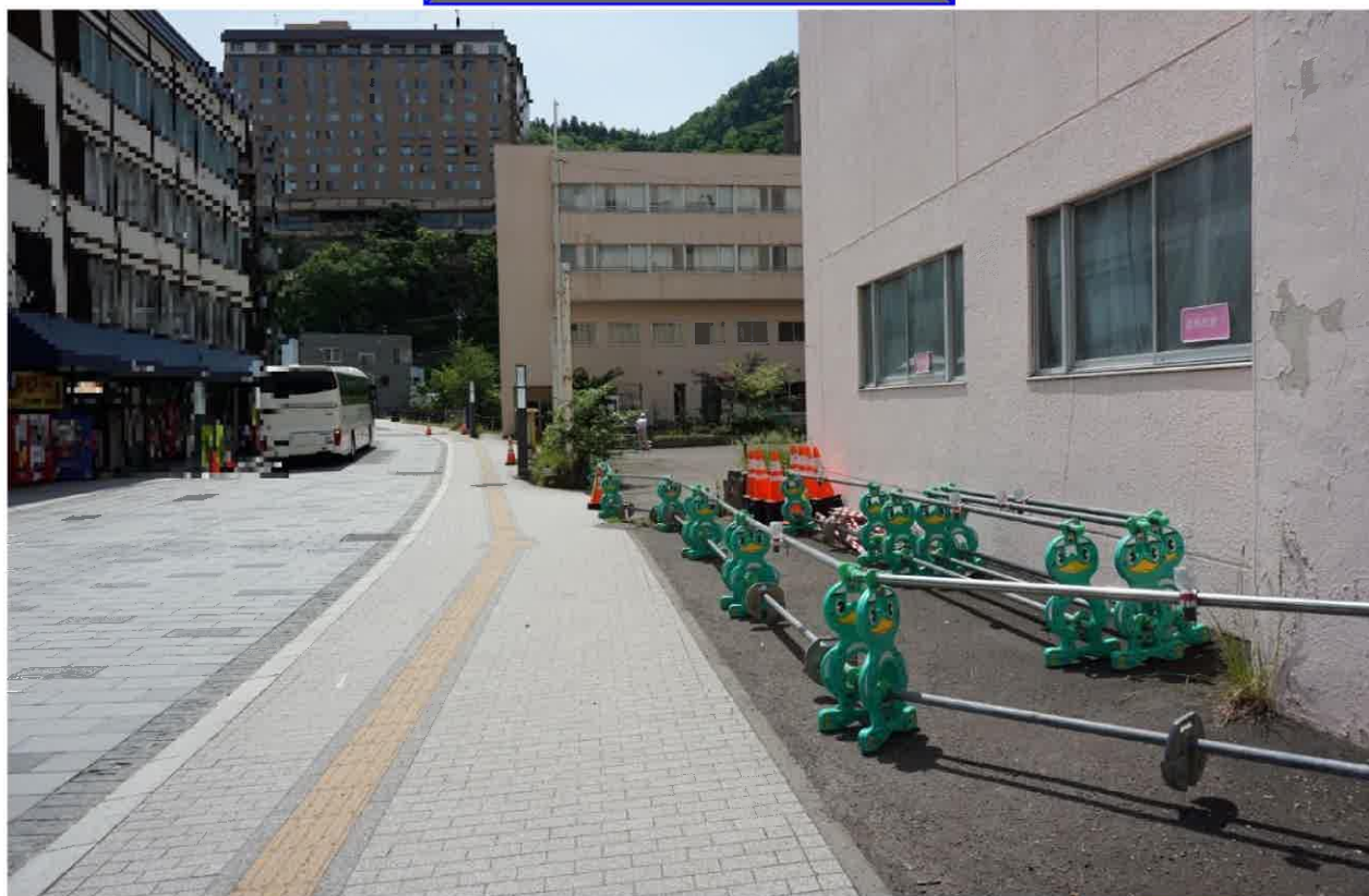
外観（北東側市道）
