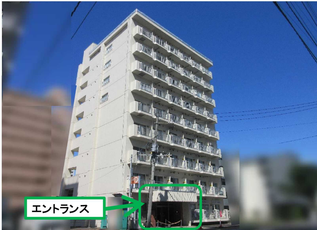
外 観（東側から）
