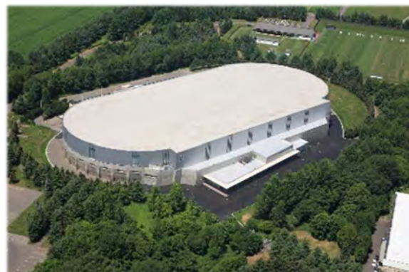
帯広の森 屋内スピードスケート場
