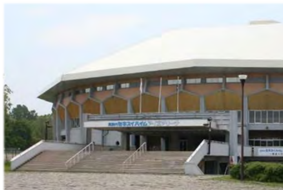
北海道立真駒内屋内競技場
