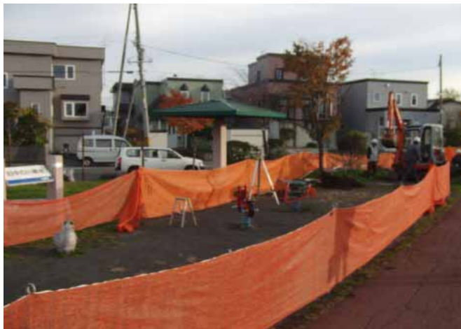
あずまやや縁台の設置工事
