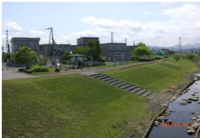
整備対象の河川敷および緑地
