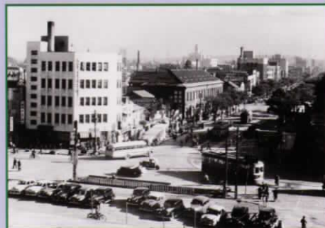
札幌駅屋上より 昭和28年(1953)10月
