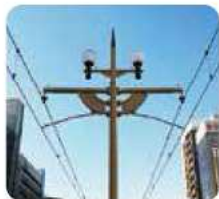
センターポール方式 景観に配慮し、電柱は軌道の中心に。ガス灯風の淡い光が行き交う電車を照らす
