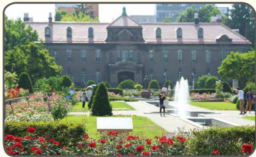
大正15年に札幌控訴院として建てられた札幌市資料館。札幌軟石を使った建物としては全国的にも貴重なもので、平成9年には国の登録有形文化財に指定された
