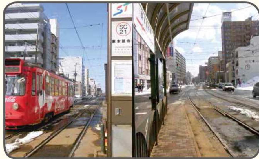
東本願寺前の内回り停留場に立って北を向くと軌道はまっすぐ。(写真:左)南を向くと軌道はカーブを描いている(写真:右)
