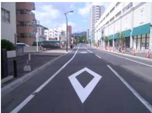
平成22年度施工 電線共同溝(円山クラッセ前)
