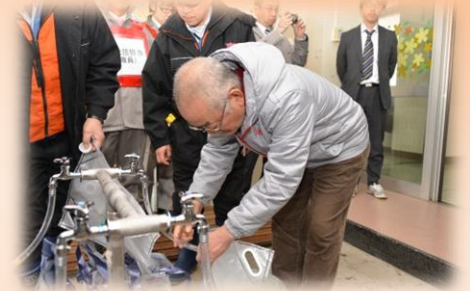
水道局による仮設給水栓の設置
