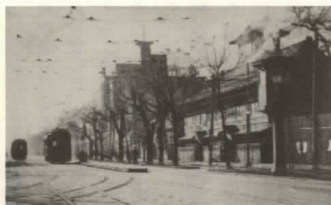
道庁前の信号塔（奥の建物はグランドホテル）「市営十周年記念写真帖（昭和17年札幌市電気局発行）」より
