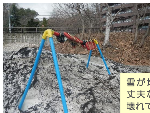
滑り台の滑る部分は、雪が堆積されると壊れやすい。
