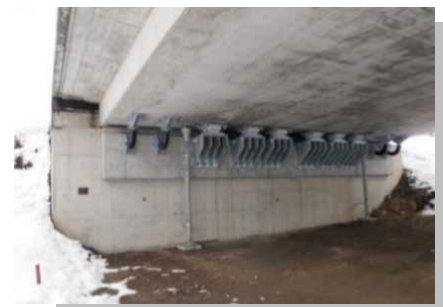
耐震補強を実施した橋りょう
