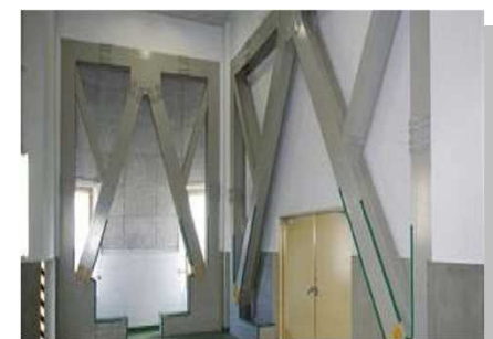
鉄骨ブレース設置による耐震化（上下水道施設）
