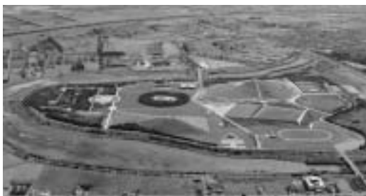
平成16年度に全面完成するモエレ沼公園
