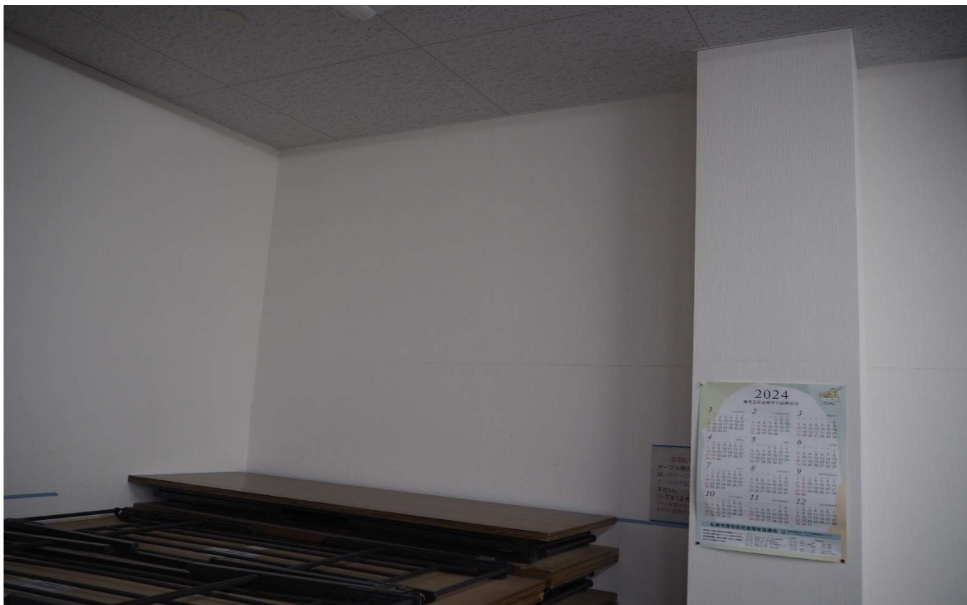
厚別西会館 設置予定箇所②
