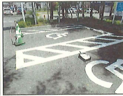
駐車場の白線の塗り直し
