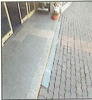
玄関前の段差を補修
