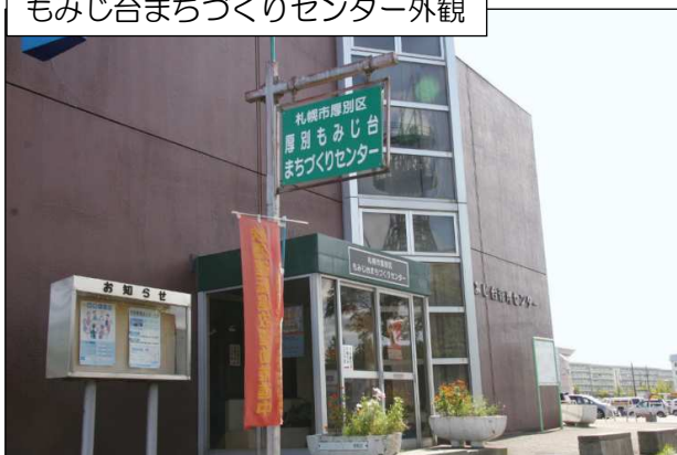
もみじ台まちづくりセンター外観
