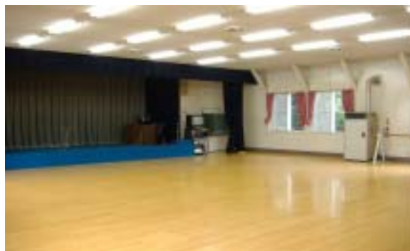
< 壁の内側には50年前の柱、梁（ホール） >
