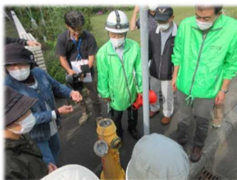
下野幌町内会 消火栓開閉実演
