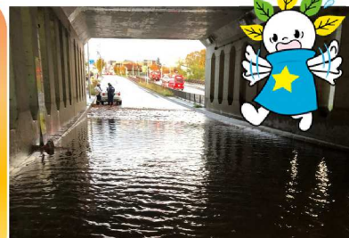
<冠水した上野幌アンダーパスの様子 (令和2年10月23日)>
