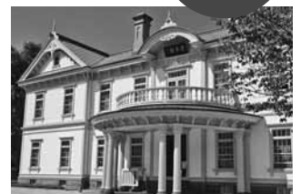
改修前の豊平館
