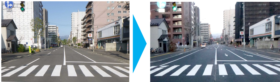
図4-10 車線数の見直しなどによる路肩幅員の確保事例
