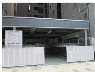
図 4-15 新設の路外駐輪場
