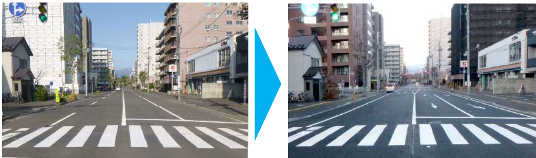
図 4-10 幅員構成の見直しによる路肩幅員の確保状況
