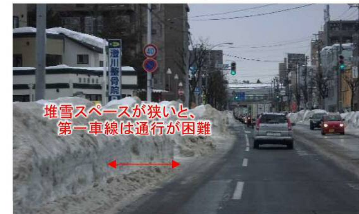
参考：堆雪スペースが狭い4車線道路の冬期間の状況
