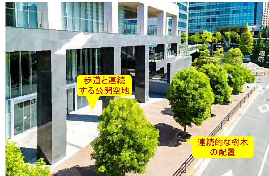
東京都大崎センタービル
