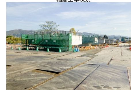
橋脚工事状況
