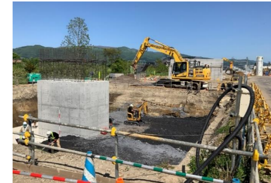
橋脚工事状況
