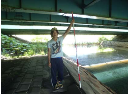
調査地遠景_上流方向
