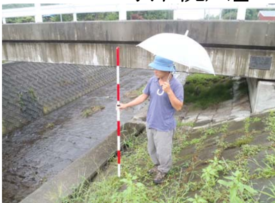
調査地遠景_上流方向
