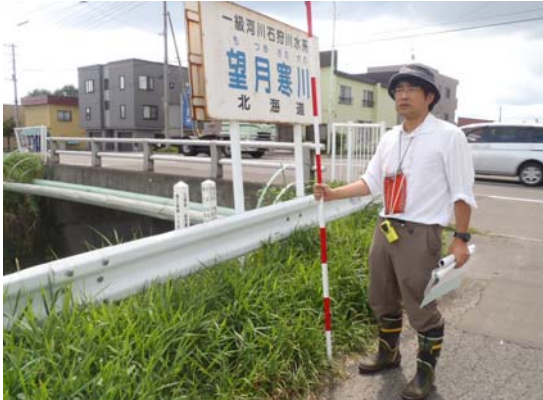
調査地遠景_上流方向
