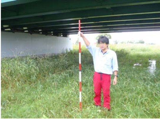
調査地遠景_上流方向
