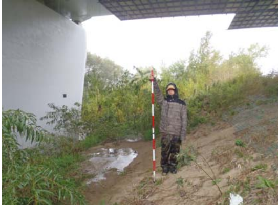
調査地遠景_上流方向
