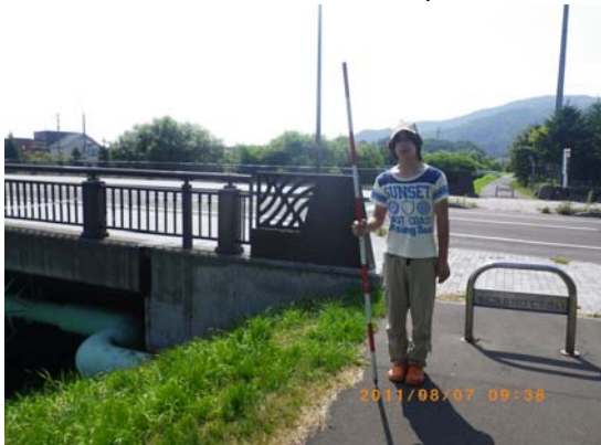
調査地遠景_上流方向
