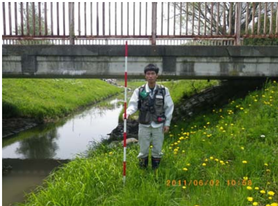
調査地遠景_上流方向
