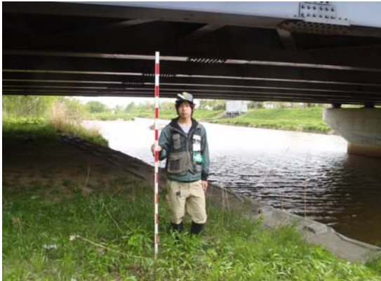
調査地遠景_上流方向
