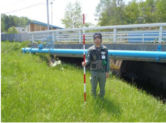
調査地遠景_上流方向
