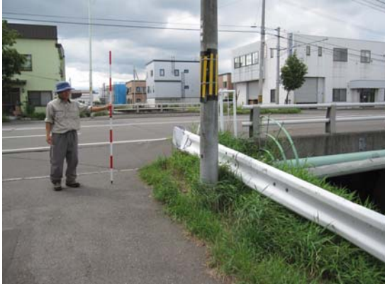
調査地遠景_上流方向
