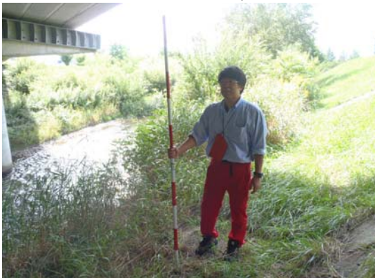
調査地遠景_上流方向
