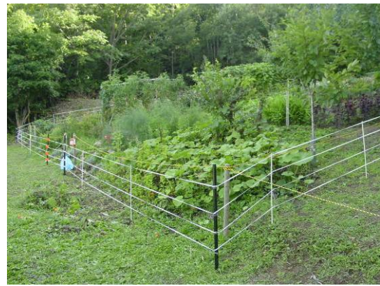
写真 3-10-3 標準的な施工例（左：3 段張り、右：4 段張り）
