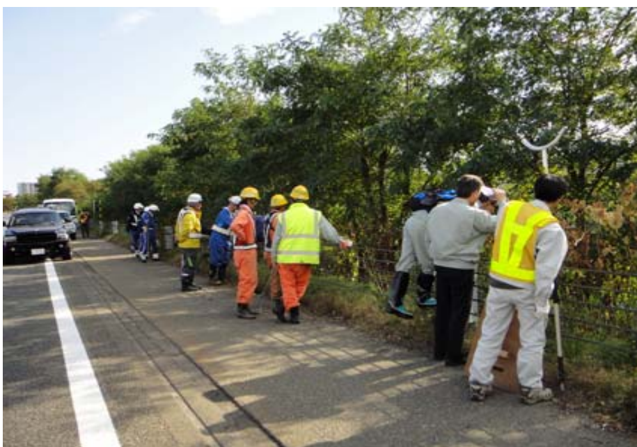
写真 2-6-6 高速道路上での作業の様子
