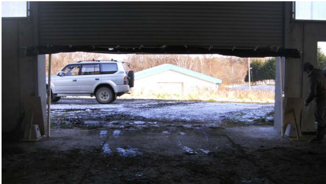
写真 2-1-6 落下扉の様子
