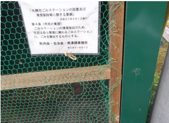
写真3 ゴミステーション(修復済み)
