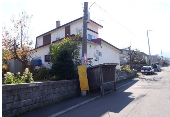
写真6 新規設置の喚起看板(遠景)
