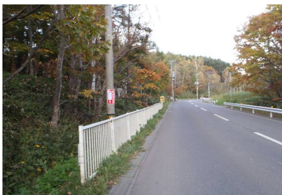
写真3 注意喚起看板(遠景)2枚目
