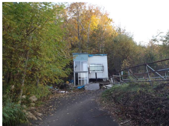
写真2 現場周辺環境
