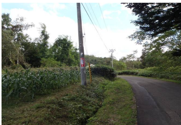
写真5 新規設置の注意喚起看板(遠景)
