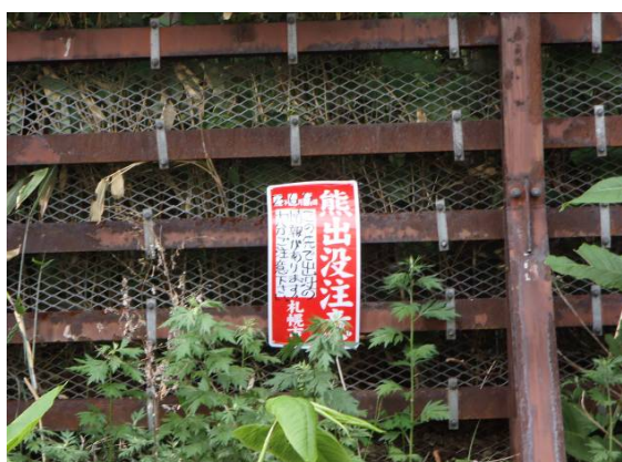
写真3 注意喚起看板設置
