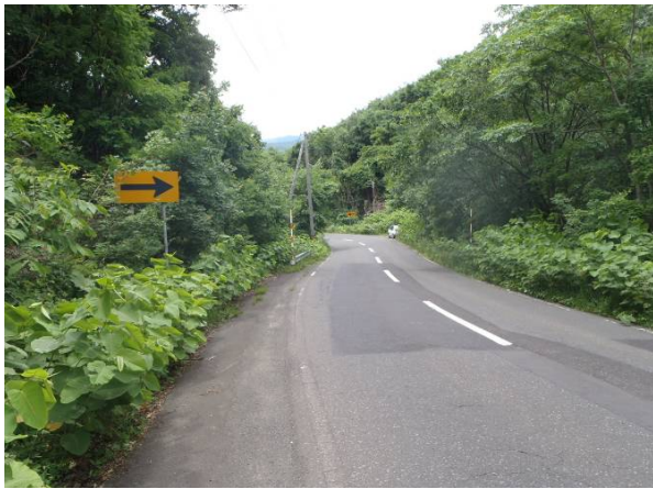
写真3 現場周辺環境
