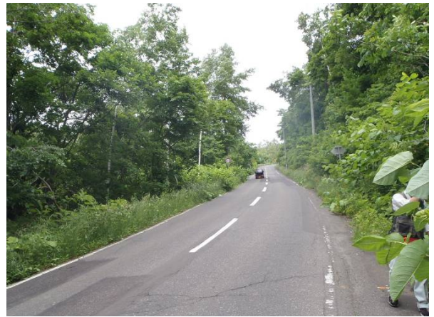
写真4 現場周辺環境
