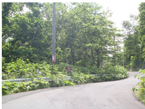
写真6 注意喚起看板設置
