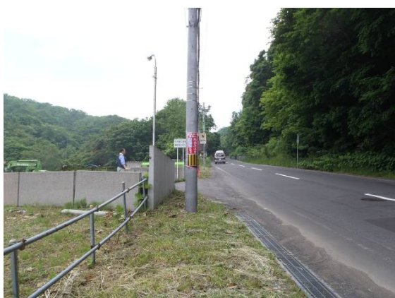
写真9 注意喚起看板 (遠景)①
