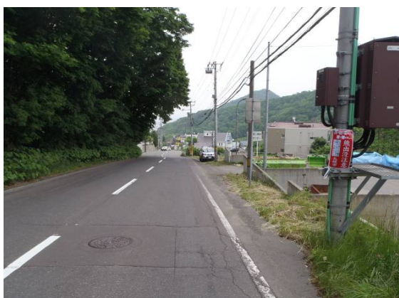
写真11 注意喚起看板 (遠景)②
