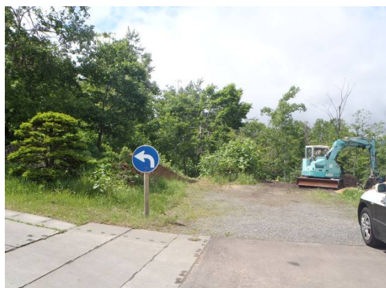
写真4 現場周辺環境
