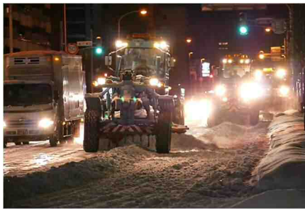
幹線道路の除雪
