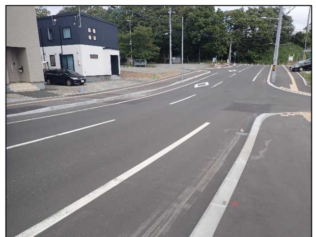
写真：復旧工事後の様子（左写真と同じ地点）
