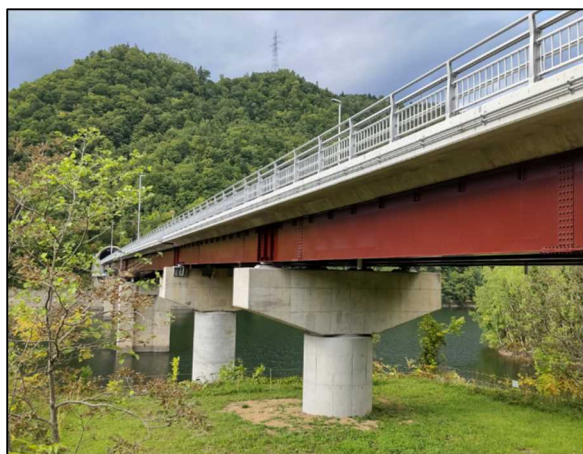
写真：耐震化工事完了後（滝の沢大橋）
