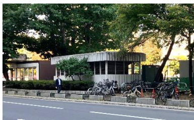
西10丁目 通気口 (公園南側)
