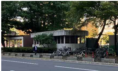
西10丁目 通気口（公園南側）
