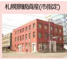
旧敷商事会社ビル (現：三誠ビル)
