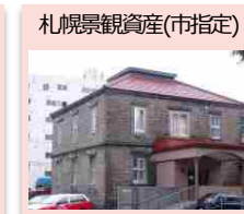
カトリック北一条教会司祭館 カテドラルホール
