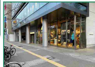
明治安田生命札幌大通ビル ・歩道沿い空地（地区計画）
