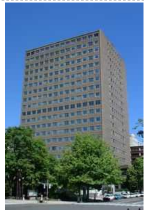
札幌市役所本庁舎 上記写真全て <資料>札幌市
