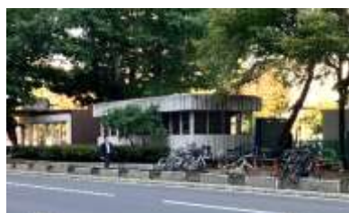
西10丁目 通気口（公園南側）
