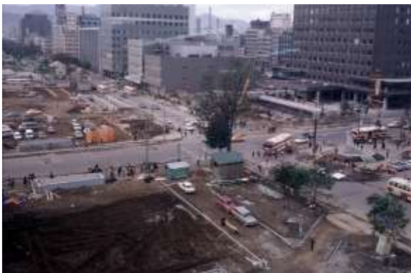
昭和46年（1971年）10月 建設中のさっぽろ地下街
