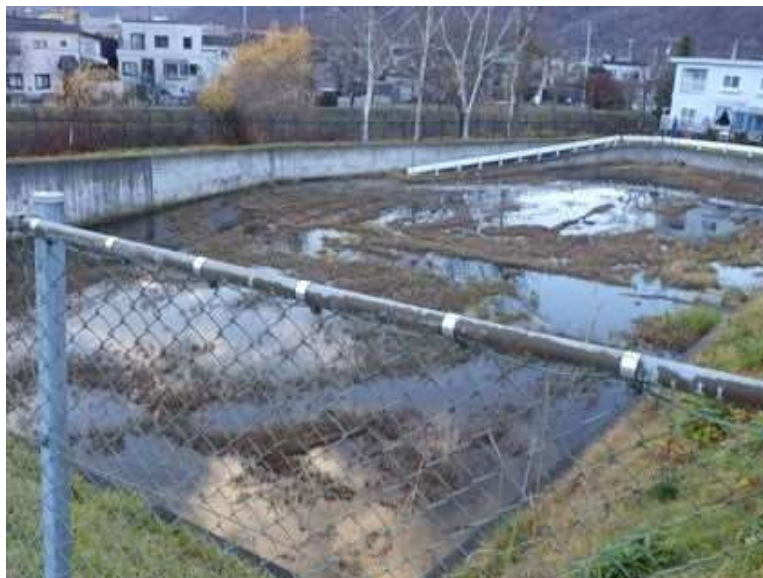
【図6-29 雨水貯留池】
