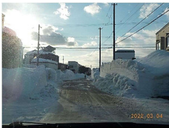
【図3-15 削った雪を寄せて完了した状況】
