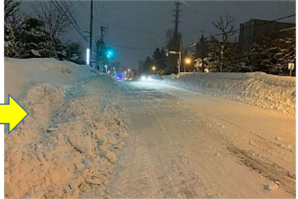
【図2-17 2月22日 新雪除雪で路肩に寄せた雪により道幅が狭くなった幹線】
