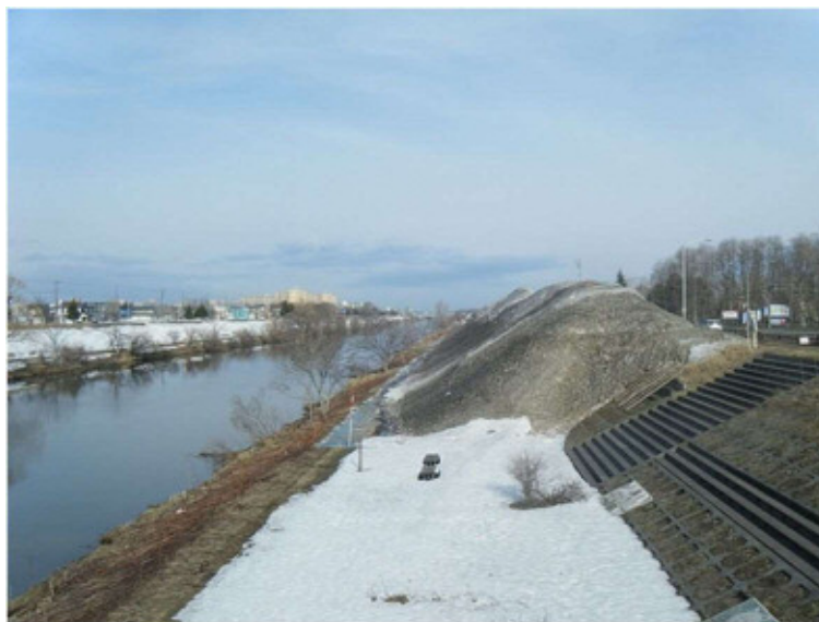
【図6-30 河川敷地雪堆積場（嵩上げ後）】
