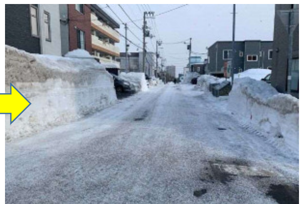
【図4-9 3月22日 緊急対応のパートナーシップ排雪後の状況】
