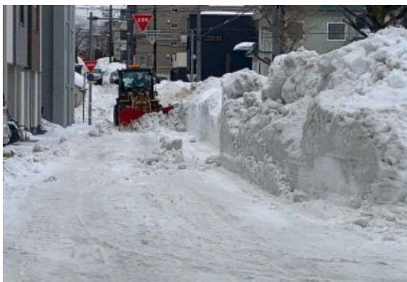
【図4-6 3月12日 路面整正の状況】
