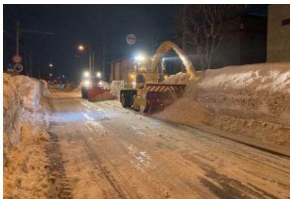
【図3-12 1月18日 拡幅除雪の状況】
