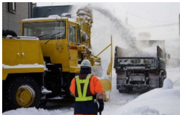
【図 6-20 幹の路線の雪を排雪する作業（イメージ）】
