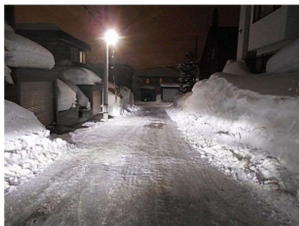
【図3-16 削った雪を寄せて完了した状況】
