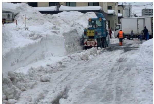
【図4-7 3月12日 拡幅除雪の状況（公園活用）】
