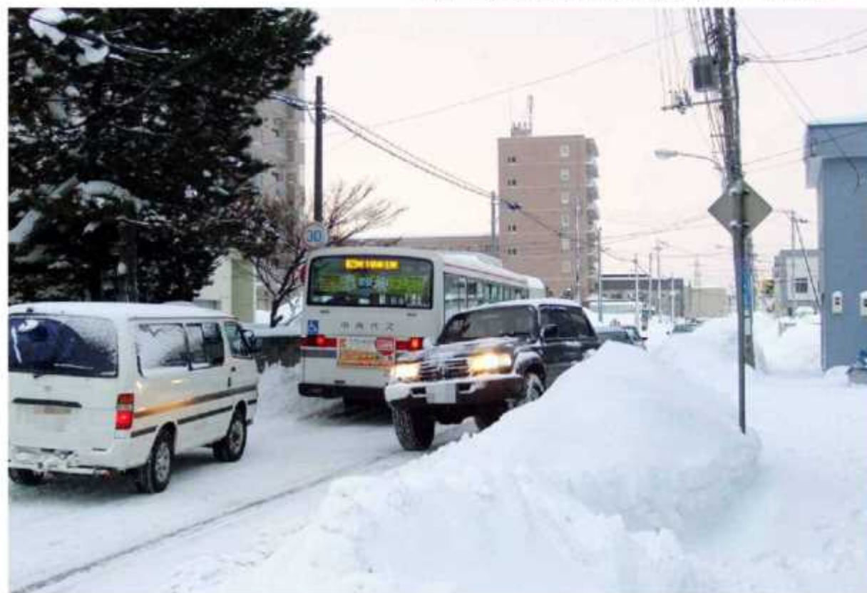
冬期に狭くなる車道の様子(H22年時点)
