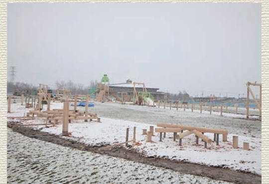
現在の工事状況
