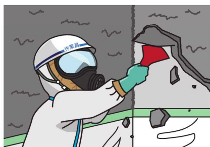
【除去】アスベスト建材を下地から取り除く工法
