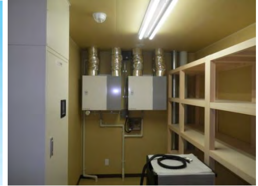
顕熱交換型換気扇 日本スティーベル社製
