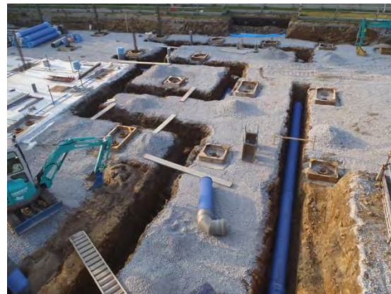
自然エネルギーを有効に活用できるアースチューブ（基礎下に設置）
