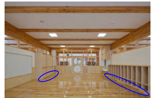
換気吹出し口 (家具下部より吹出し)
