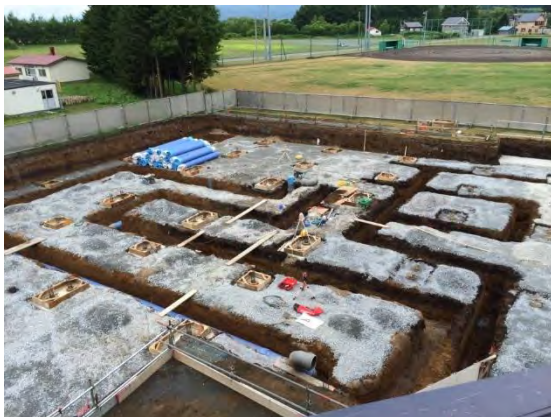
自然エネルギーを有効に活用できるアースチューブ（基礎下に設置）
