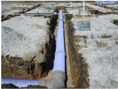
アースチューブ（熱交換器） 積水化学社製
